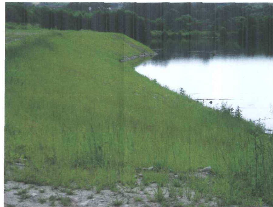
Berge talutée et engazonnée (plan d'eau Sud-Est)
