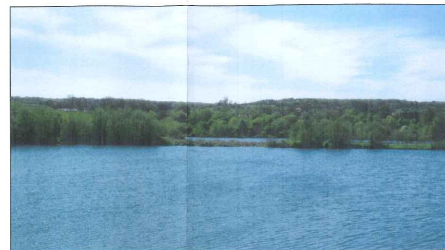
Seuil amont sur la Moselle
